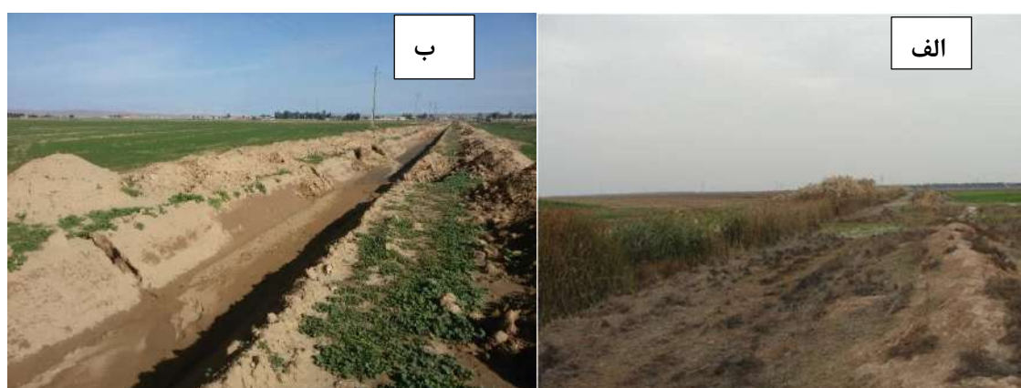
شکل ۳. زهکش اصلی MD2 قبل از لایروبی (الف) و بعد از لایروبی (ب)
