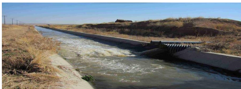
شکل ۱. کانال جمع‌آوری و خروجی آب تصفیه‌شده تصفیه‌خانه کرمانشاه
