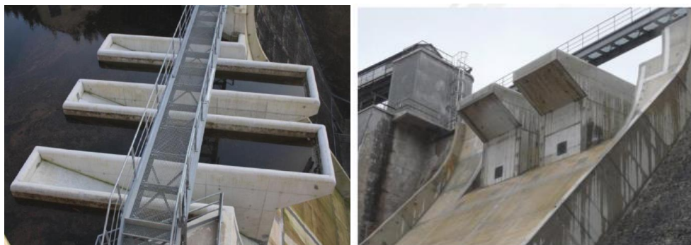
شکل ۱. نمونه‌ای از سرریز کلید پیانویی مورد استفاده در سد بتنی (سد اترویت در فرانسه)
