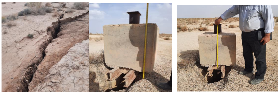
شکل ۸. فرونشست اتفاق افتاده در محدوده دشت دامغان شامل ترک در سطح زمین و فرونشست اطراف پی‌زومتر مشاهداتی
